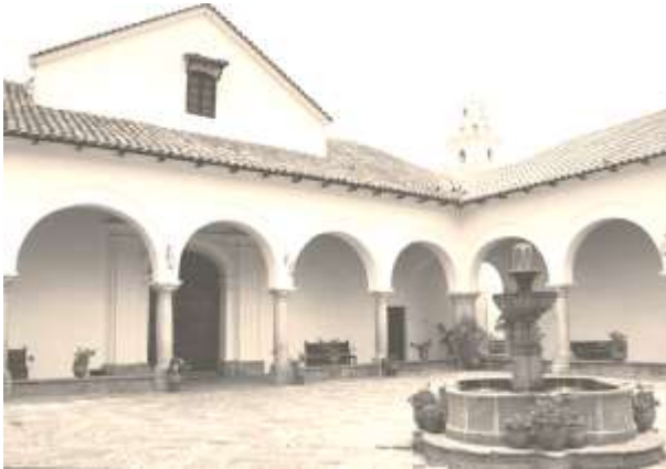
Imagen 27. Vista Claustro mayor. Real Academia Platense de San Francisco Xavier. Actual Casa de la libertad.
